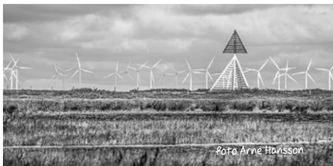
Vindkraftpark vid Skanör. Bild från höstutflykten
